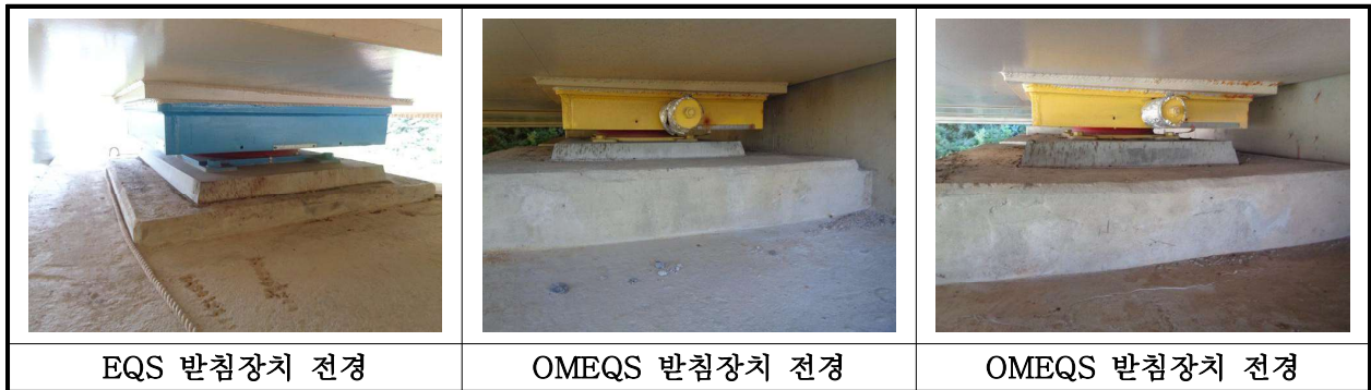
【사진 6.3.12】 교량받침 전경
