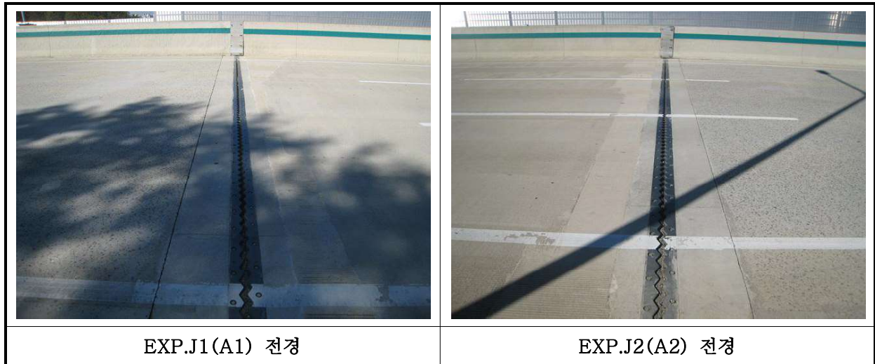
【사진 6.3.16】 신축이음장치 전경
