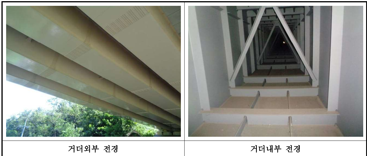
【사진 6.3.4】 거더 전경
