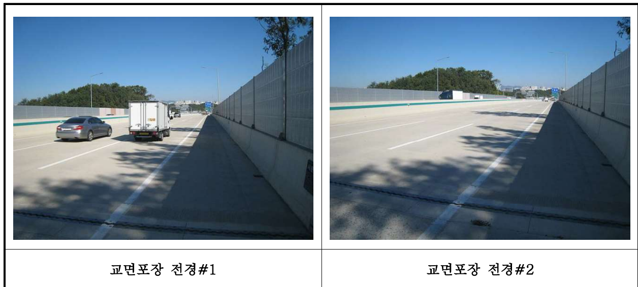
【사진 6.3.19】 교면포장 전경
