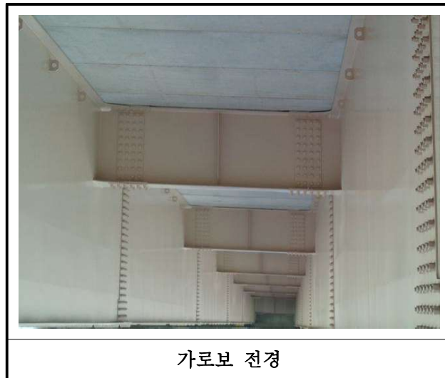
【사진 6.3.6】 가로보 및 세로보 전경
