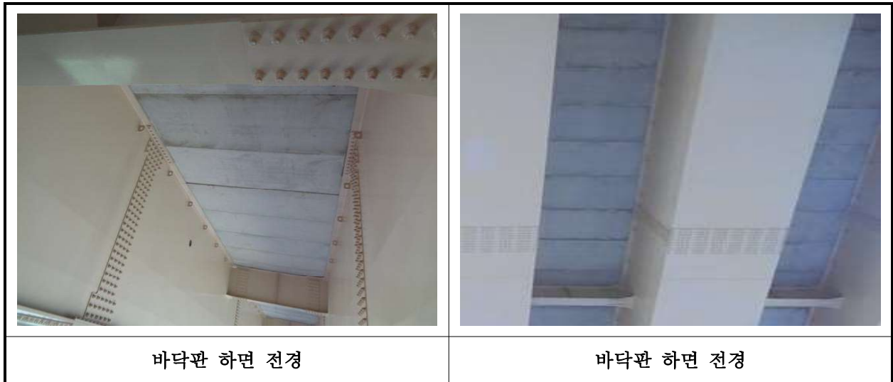
【사진 6.3.2】 바닥판하면 전경
