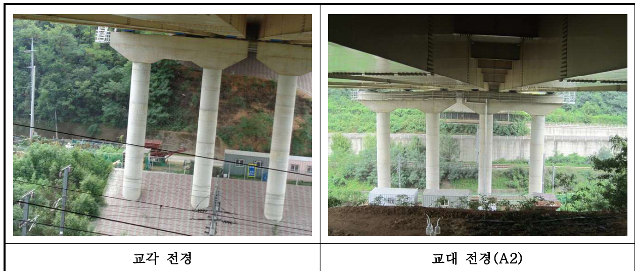
【사진 6.3.10】 교각 전경
