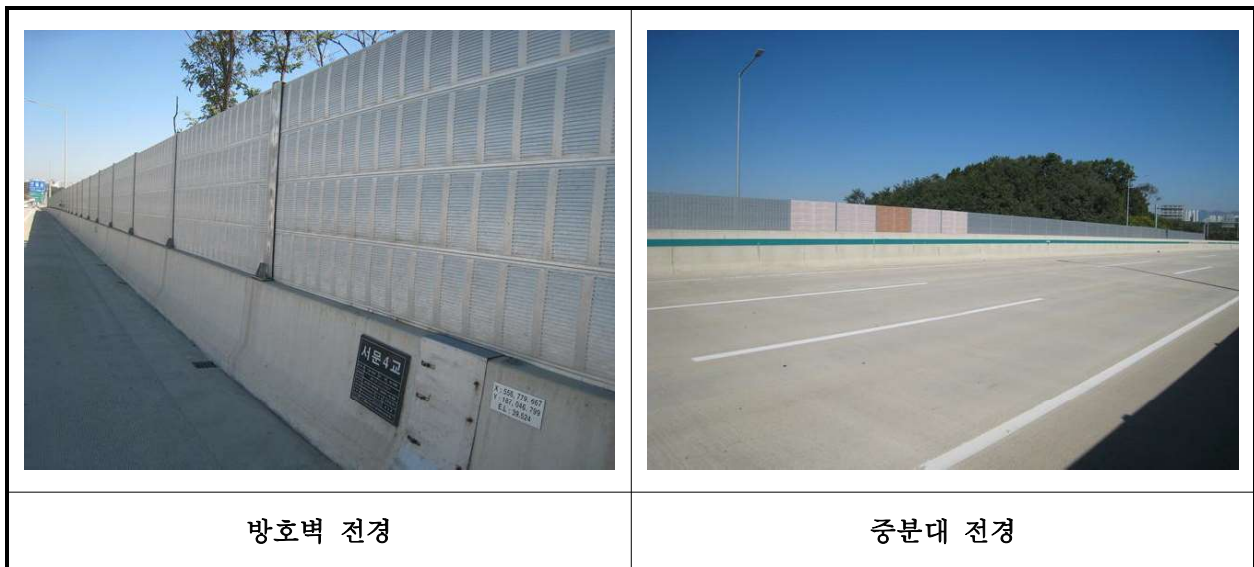
【사진 6.3.23】 방호벽 및 중앙분리대 전경
