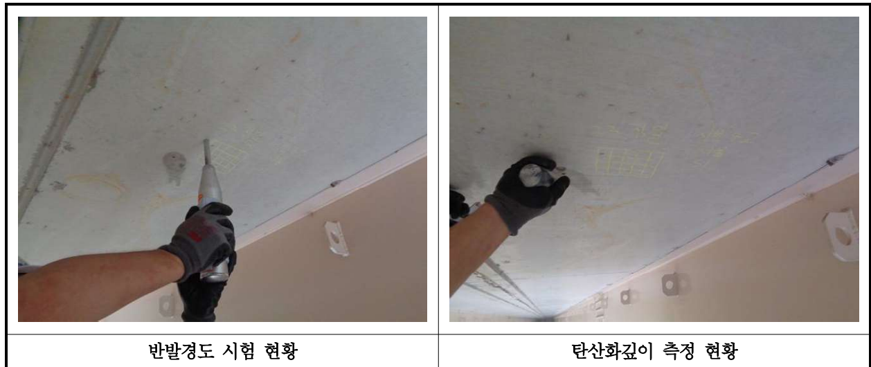
【사진 6.4.1】 콘크리트 내구성조사 현황
