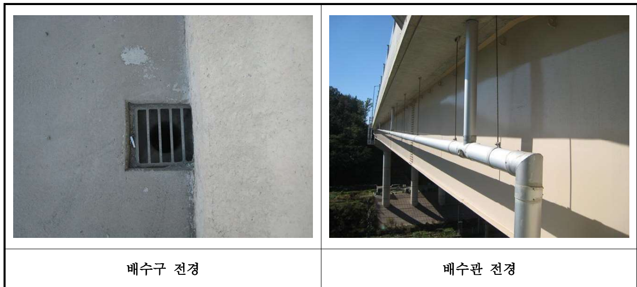
【사진 6.3.21】 배수시설 전경
