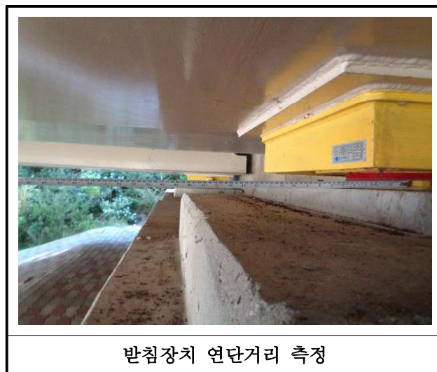
【사진 6.3.14】 교량받침장치 연단거리측정
