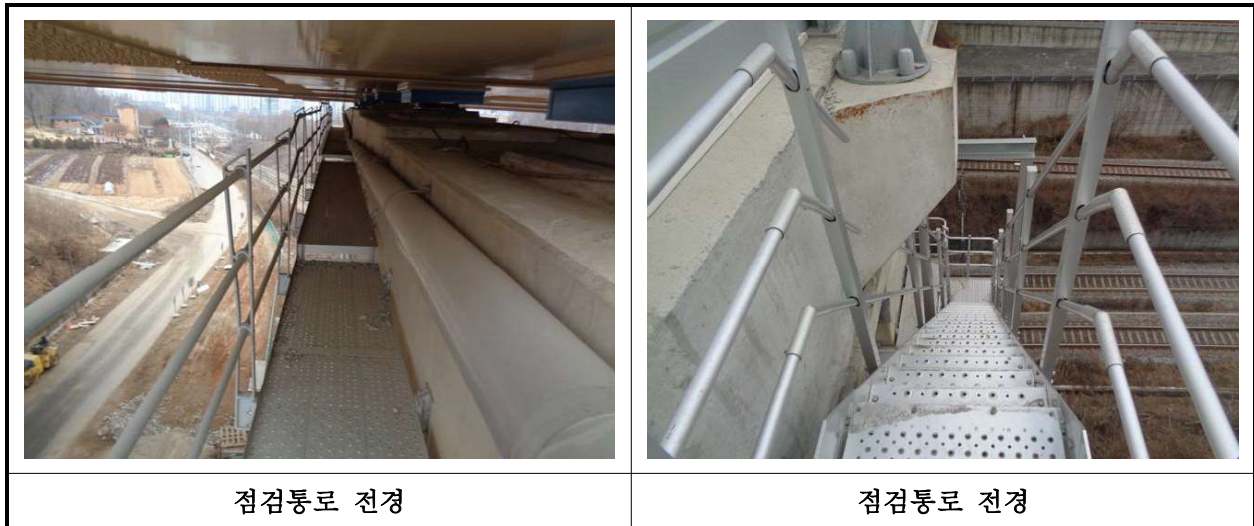
【사진 6.3.25】 교량 점검시설 전경
