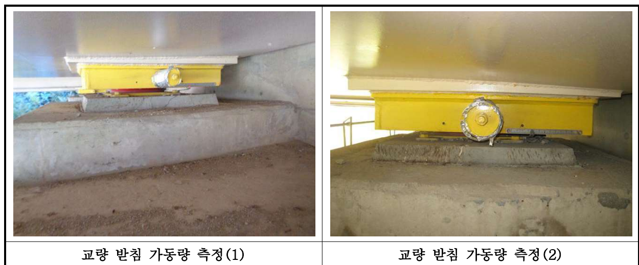
【사진 6.3.15】교량받침 이동량 측정
